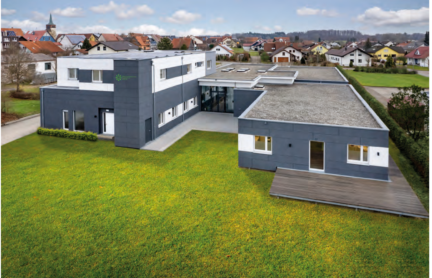
Multifunktionaler Beitrag zur ländlichen Gesundheitsversorgung: Ein herausragendes Beispiel ist das Port Gesundheitszentrum Schwäbische Alb Hohenstein, das aus mehreren FlyingSpaces besteht. Dort entstanden Praxen, Beratungsstellen und Räume für Begegnung – ein Leuchtturmprojekt für die medizinische Versorgung im ländlichen Raum.
