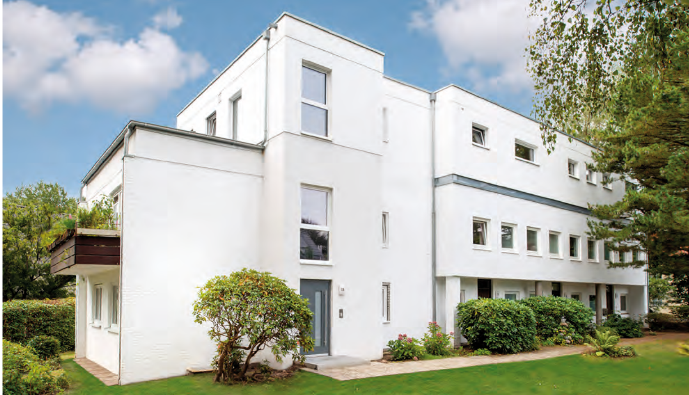
Aufstockung Hamburg: Wertvollen Wohnraum schaffen im Bestand zeigt die Aufstockung eines Gebäudekomplexes in Hamburg: mit passgenauen und vorgefertigten Bauteilen wurde innerstädtisch ohne große Eingriffe in die Umgebung wertvoller Wohnraum geschaffen und das gesamte Gebäude aufgewertet.
